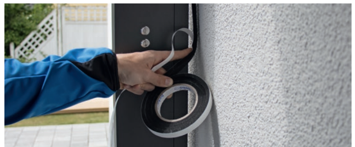
Elementi in acciaio
